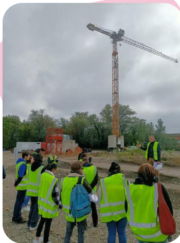
Visite de chantier |
